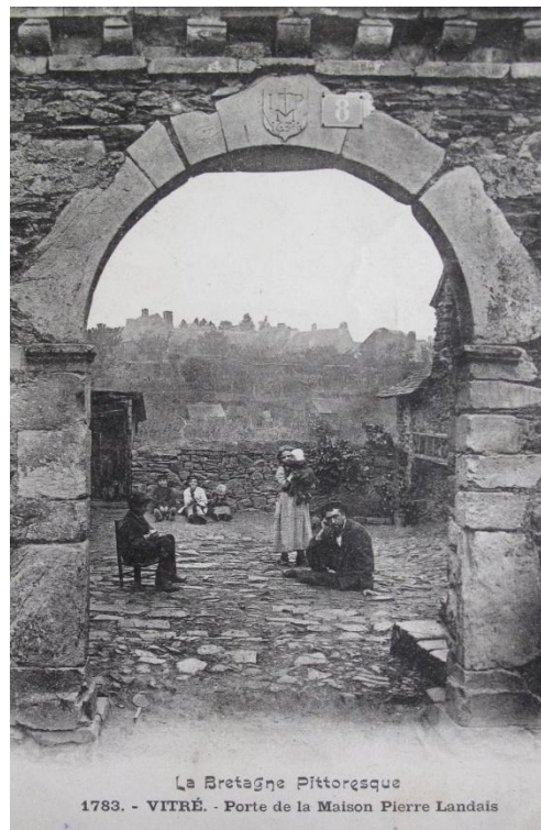
Entrée de la demeure de Pierre Landais, reconstruite au XVII e , rue de la Greurie, Vitré. (Collection privée)
